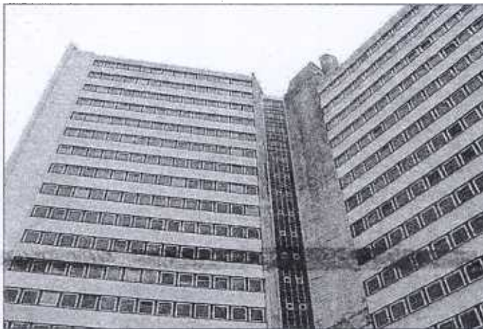
Trop chère, la réhabilitation du Tripode a été abandonnée. Le bâtiment va être désamianté puis détruit.
